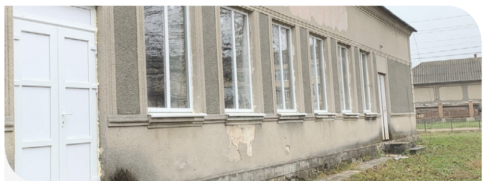
Нові енергозберігаючі вікна в Будинку культури у Балківцях
