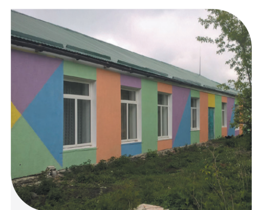
Фасад садочка у Юринцях після ремонту
