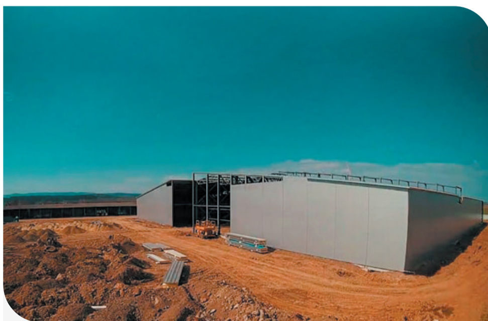
Будівництво картоплесховища в с. Чуква, Львівська обл.
